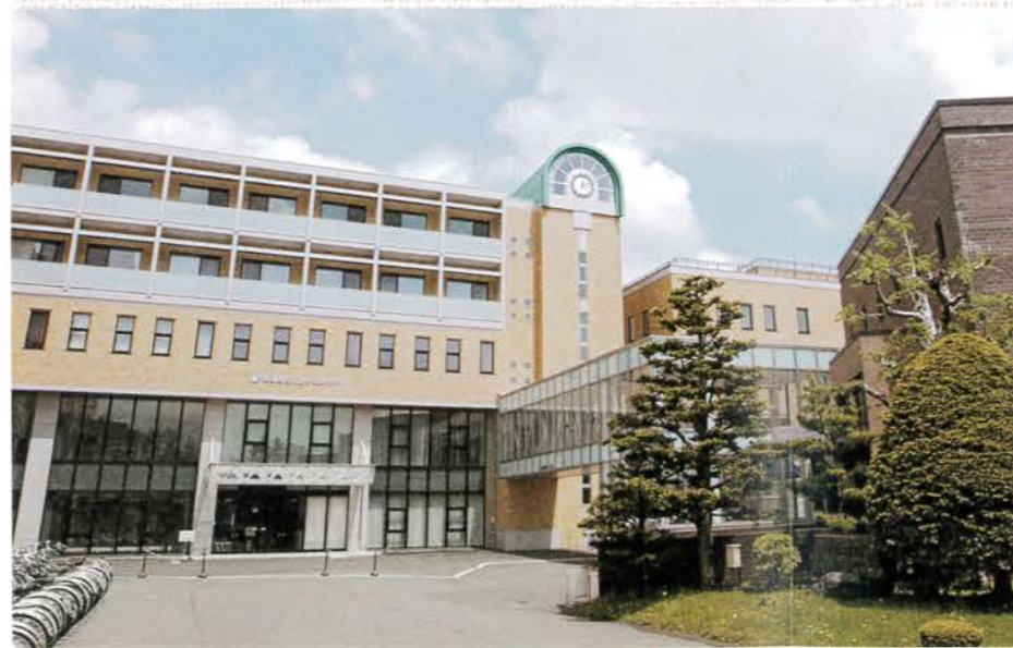
正門から新正面玄関をのぞむ 向かって右側が図書館への渡り廊下 シンボルタワーがそびえ堂々とした 校舎になりました。
